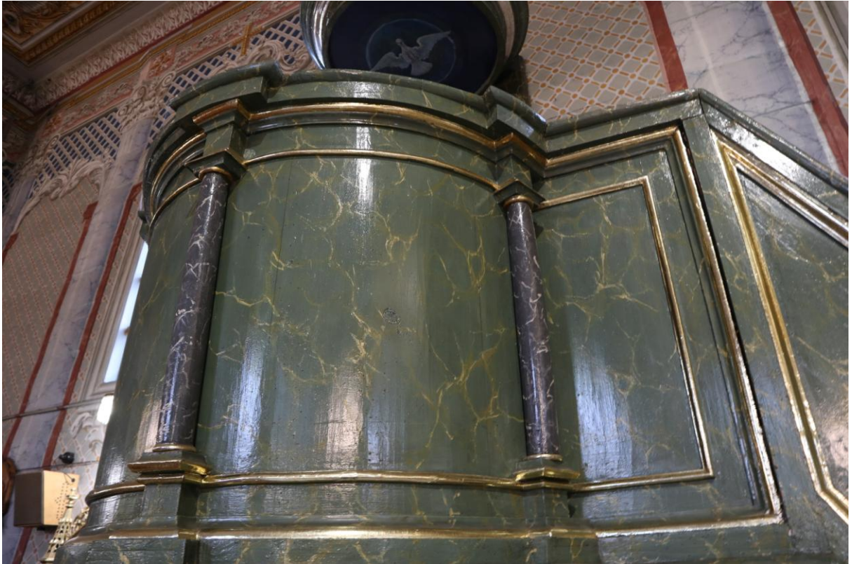
Fot. 2. Tyrawa Solna, kościół pw. Św. Piotra i Pawła, nawa, ambona, kosz (fragm.) 1 poł. XIX w. Widok ogólny. Stan przed konserwacją. Widoczne XX-wieczne przemalowanie. Fot. M. Ptańska
