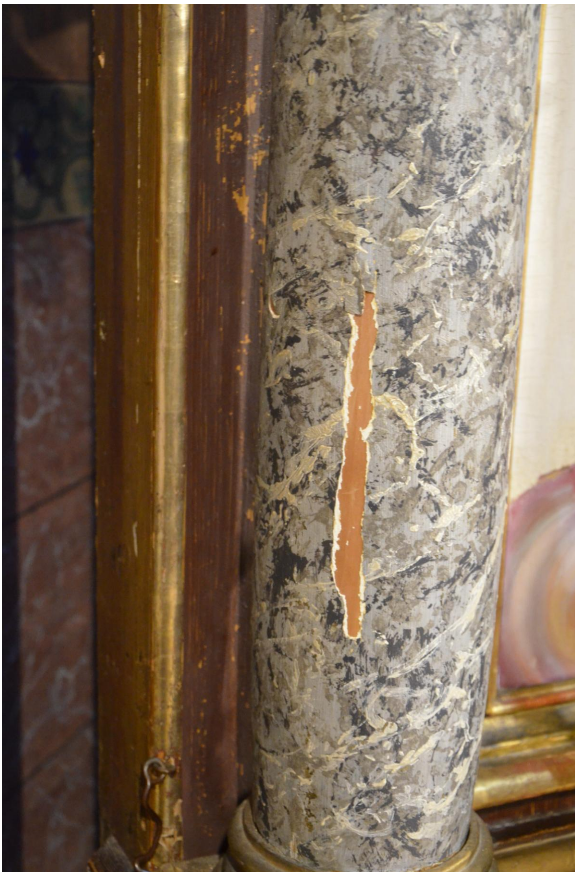
Fot. 13. Kostarowce, kościół pw. Narodzenia NMP, prezbiterium, ikonostas (fragm.), XIX w.. Stan przed konserwacją. Widoczny znaczny ubytek warstwy zaprawy wraz z warstwą malarską. Fot. A. Opalińska
