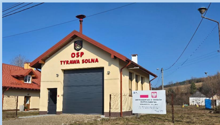
Budynek remizy OSP Tyrawa Solna
