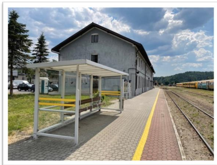
Fotografia 10. Stacja kolejowa Zagórz
