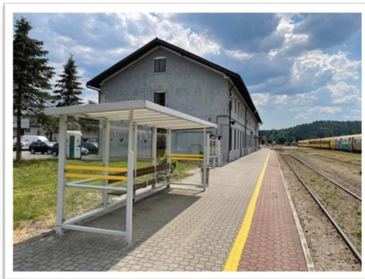
Fotografia 10. Stacja kolejowa Zagórz
