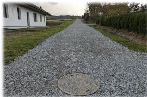
Fot. 11 Strachocina – droga do gruntów rolnych położona na dz. nr ew. 1594
