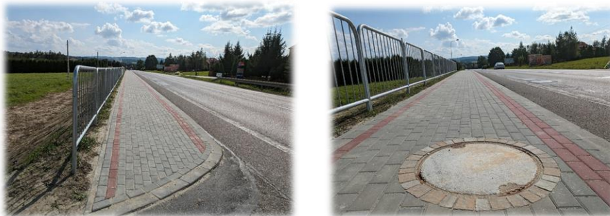
Fot. 7, 8 - Czerteż- chodnik przy drodze krajowej nr 886 Domaradz – Sanok
