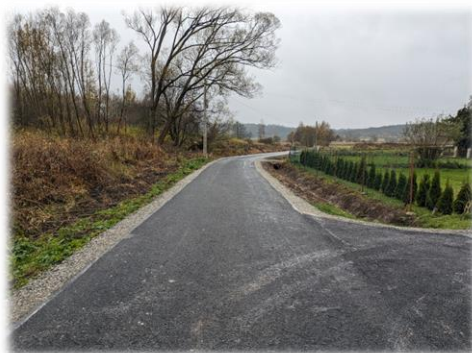
Fot. 12 Strachocina – droga do gruntów rolnych położona na dz. nr ew. 1841
