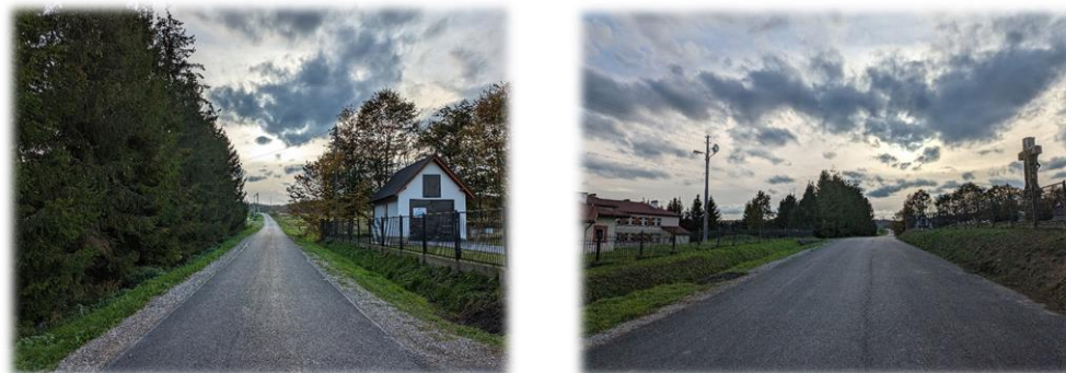
Fot. 9, 10 Strachocina – remont drogi gminnej na dz. nr ew. 1859
