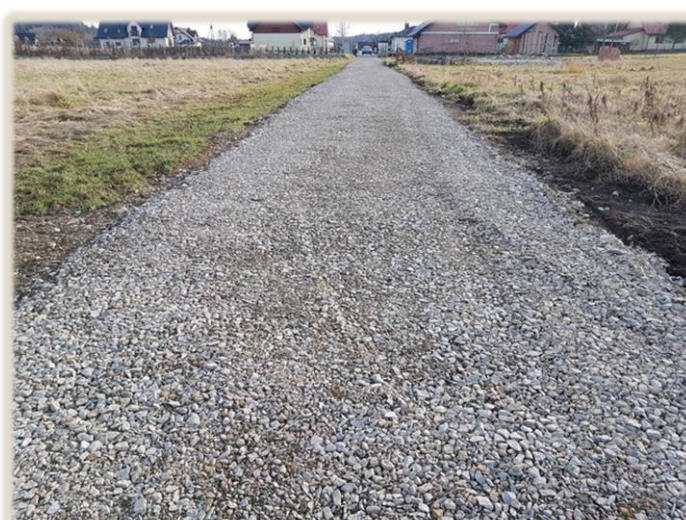
Fot. 41, 42 Wykonanie nawierzchni z kamienia łamanego w ciągu drogi „k. P. Ziarki” w miejscowości Zabłotce
