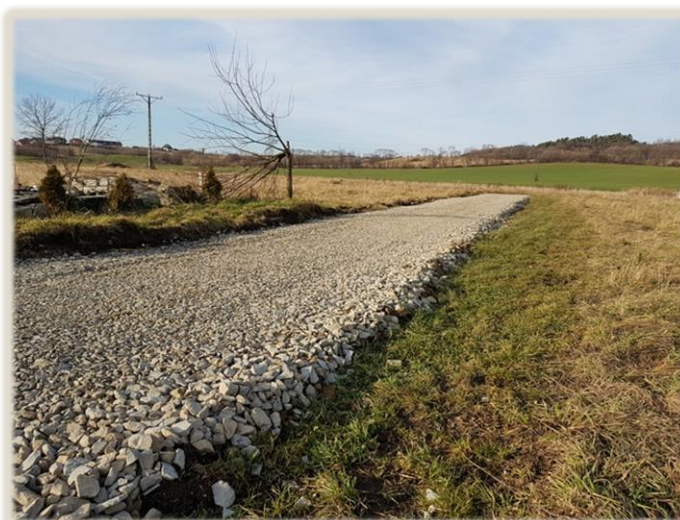
Fot. 41, 42 Wykonanie nawierzchni z kamienia łamanego w ciągu drogi „k. P. Ziarki” w miejscowości Zabłotce
