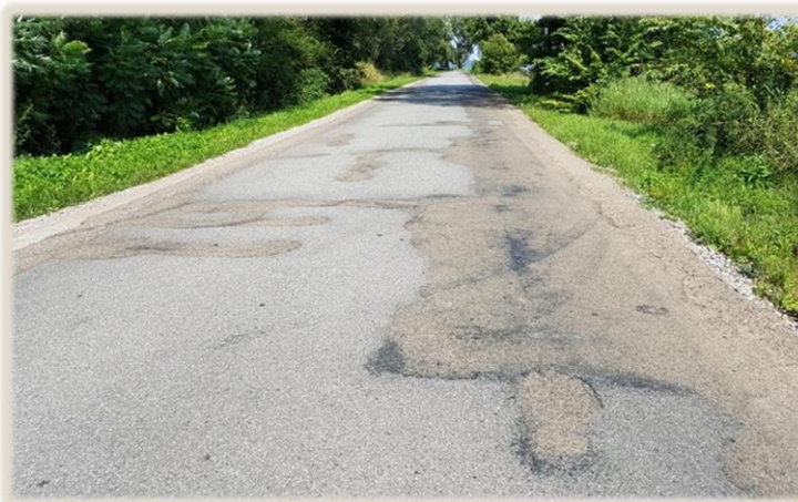
Fot. 32 Uszczelnienie spękań zmęczeniowych na drodze gminnej Pisarowce - Kostarowce
