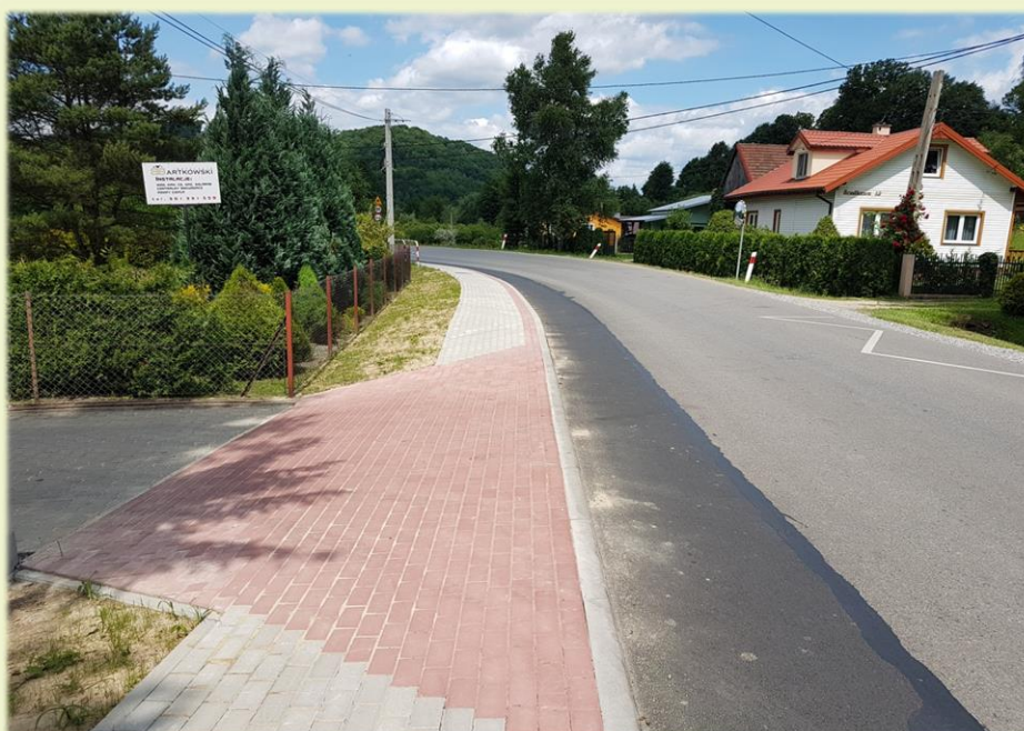
Przebudowa drogi powiatowej nr 2217R Jurowce – Trepcza od km 4+005 – 4+117 polegająca na budowie chodnika w miejscowości Trepcza
