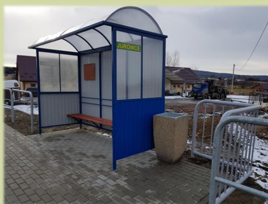
Fot. 4. Wiatę przystankowa na wykonanej zatoce autobusowej w ciągu drogi wojewódzkiej nr 886 Domaradz – Sanok w km 26+461 str. prawa w m. Jurowce.
