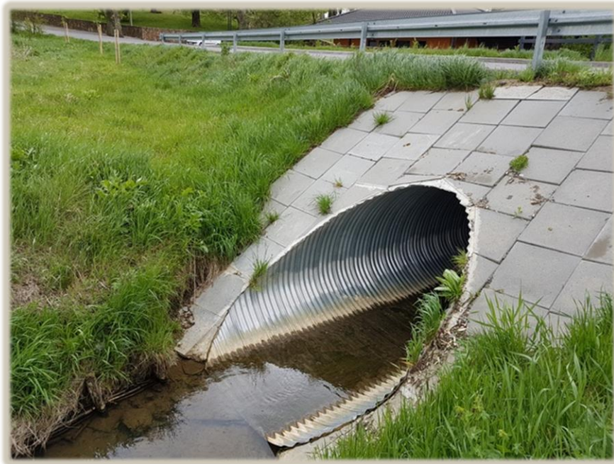
Fot. 11. Przebudowa przepustu w km o+179 - o+185 w miejscowości Strachocina.
