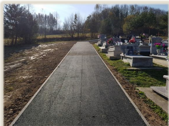
Fot. 39, 40 Wykonanie alejek z nawierzchni asfaltowej na cmentarzu komunalnym w miejscowości Dobra.
