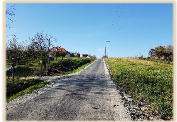
Przebudowa drogi gminnej w m. Prusiek
