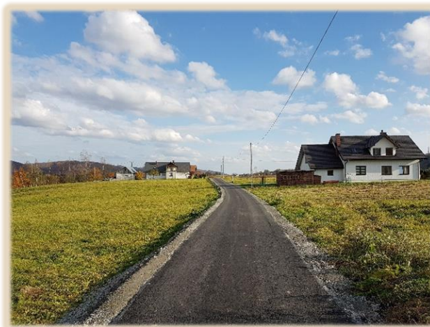
Przebudowa drogi gminnej w m. Srogów Dolny
