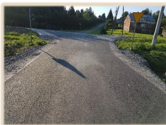
Nakładka asfaltobetonowa w ciągu drogi gminnej „w kier. Centrum” w m. Sanoczek
