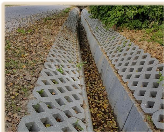
Umocnienie rowów przydrożnych w ciągu drogi wew. ul, Glinice w m. Trecza
