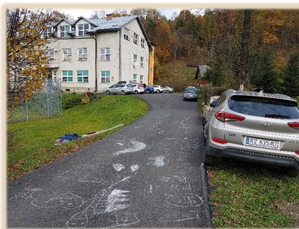
Przebudowa placu i drogi gminnej w m. Dobra
