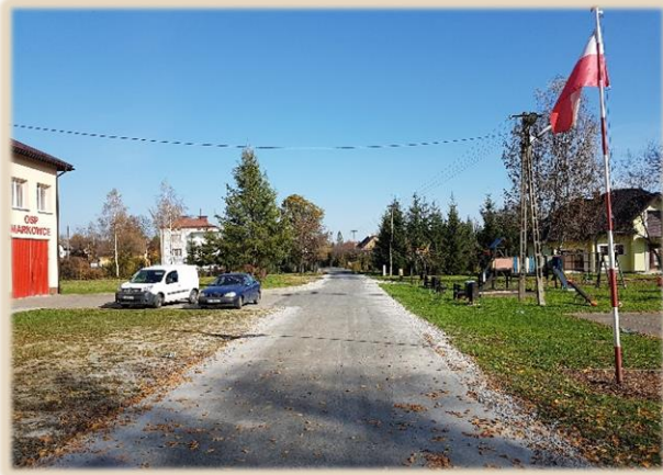
Przebudowa drogi gminnej w m. Markowce
