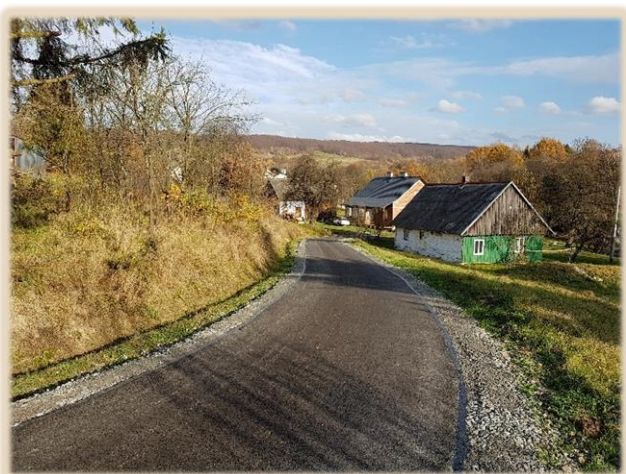
Przebudowa drogi gminnej w m. Raczkowa
