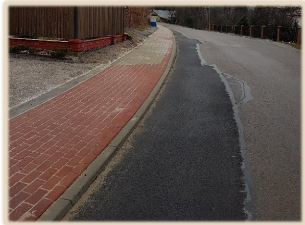
Budowa chodnika z kostki betonowej w ciągu drogi wew. gminnej w m. Srogów Górny
