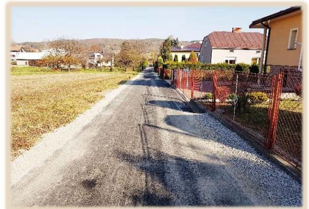
Przebudowa drogi gminnej w m. Pisarowce
