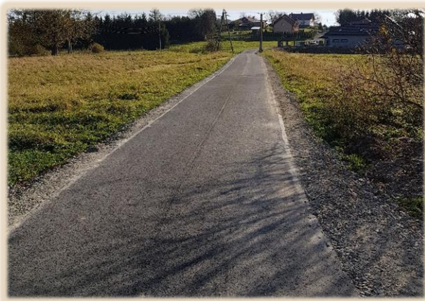
Przebudowa drogi gminnej w m. Zabłotce
