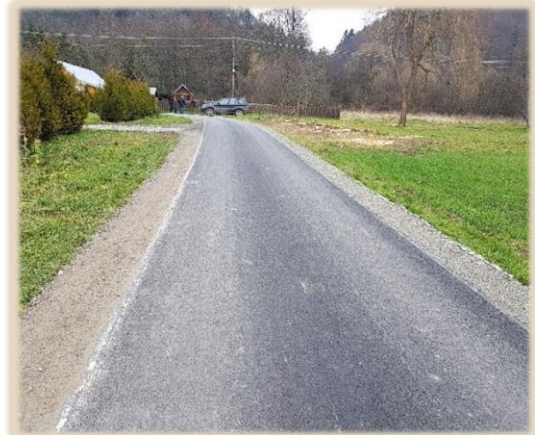
Nakładka asfaltobetonowa oraz utwardzenie poboczy w ciągu drogi gminnej „na Osiedlu Łąki” w m. Załuż
